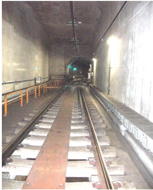
ガードレール設置状況
