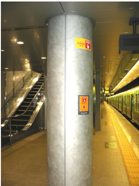
ホーム異常通報装置
