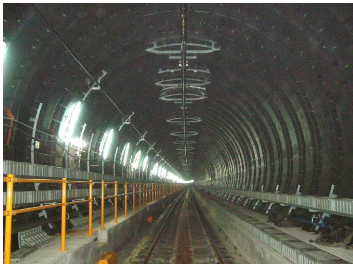
なにわ橋駅～天満橋駅間 シールドトンネル
