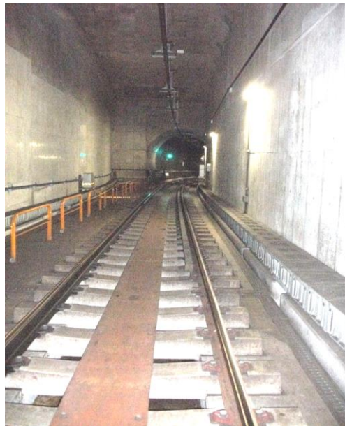
ガードレール設置状況
