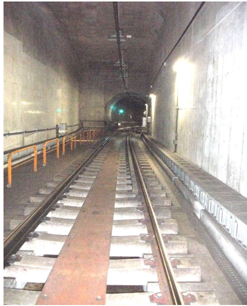
ガードレール設置状況
