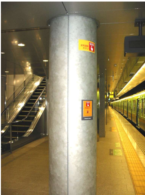
ホーム異常通報装置
