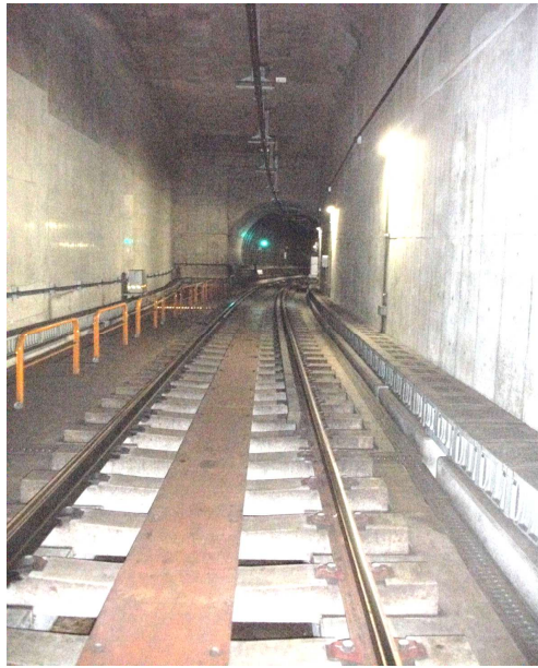
ガードレール設置状況
