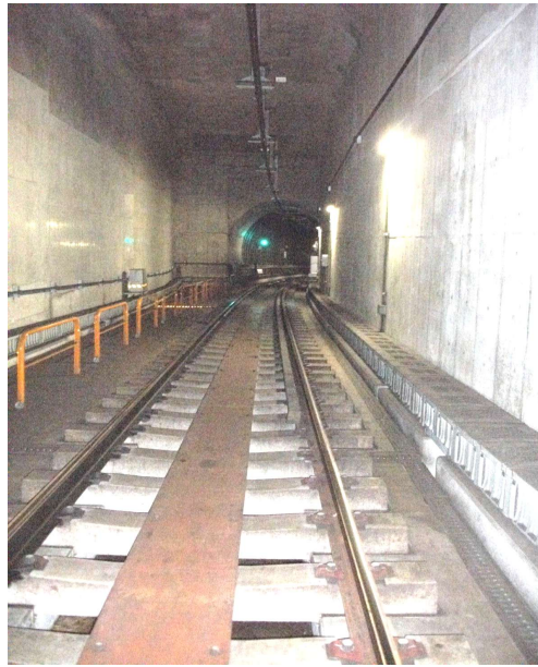
ガードレール設置状況
